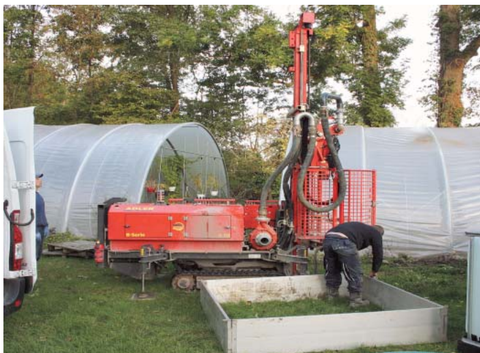
Die Bauarbeiten zum Solarbrunnen erfordern schweres Gerät. (Foto: Jörg Lindemann)
